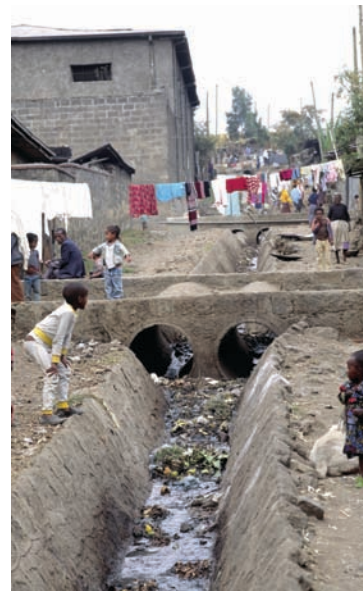
Alcantarillas a cielo abierto en una zona de suburbios de Abeba, Etiopía
