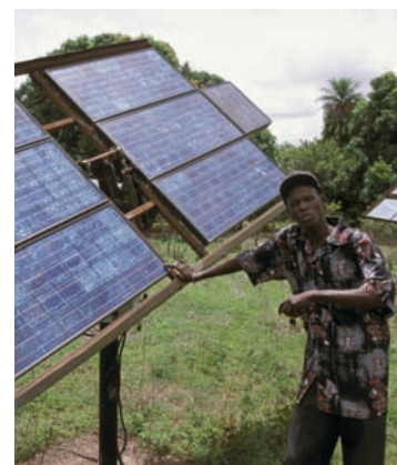
Este panel de energía solar fotovoltaica se utiliza para bombear agua, pueblo de Kabekel, Gambia
