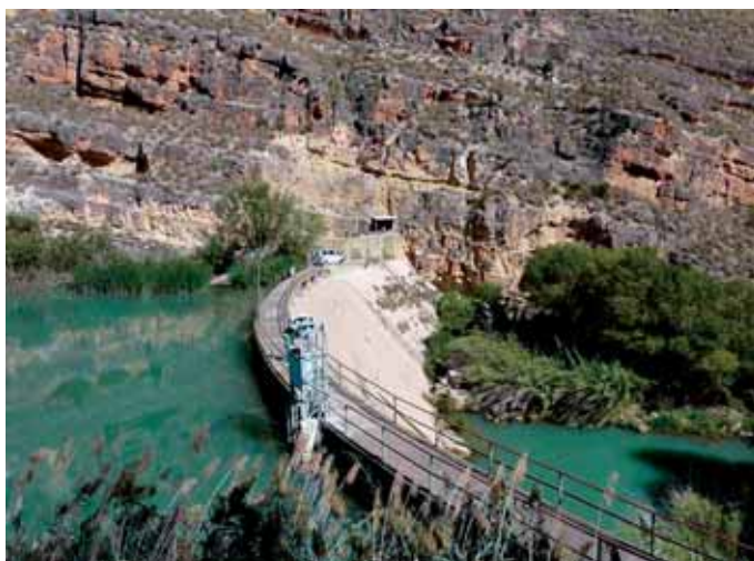
Presa de La Mulata. Central Hidroeléctrica de Almadenes. Calasparra, Murcia.
