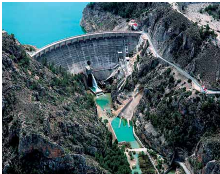
Presa del Embalse de la Fuensanta en Yeste (Albacete).
