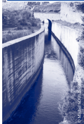
Al Hama interbasin transfer canal - Al Hama, Genil
