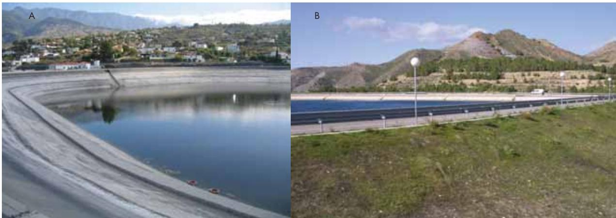
FIGURA 3. Geomembranas sintéticas termoestables en la impermeabilización de las balsas: A) Los Dos Pinos (Los Llanos de Aridane) y B) La Casa de las Chumberas (Lorca).
