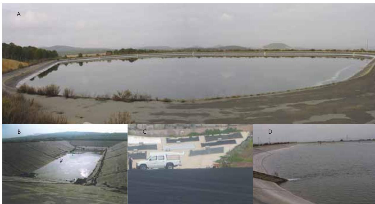
FIGURA 2. Balsas impermeabilizadas con caucho terpolímero de etileno-propileno-monómero diénico: A) Bullas (Murcia). B) Bigastro (Alicante). C) El Saltadero (Tenerife). D) Los Pozos (Murcia).
