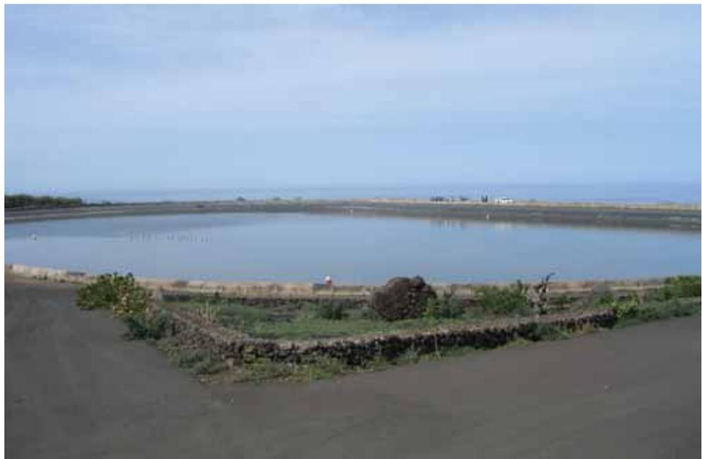
**FIGURA 9.** Geomembrana de EPDM que forma parte del sistema impermeabilizante del vaso de la balsa de El Golfo.
