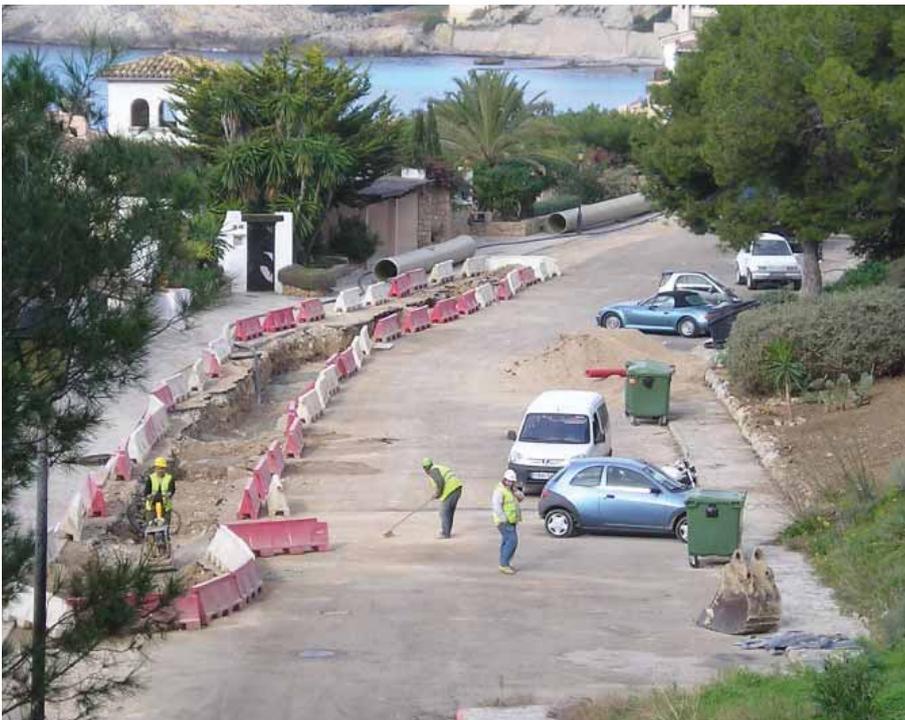
FIGURA 3. Limpieza de la zona de conducción desde los pozos de captación hacia la IDAM.
