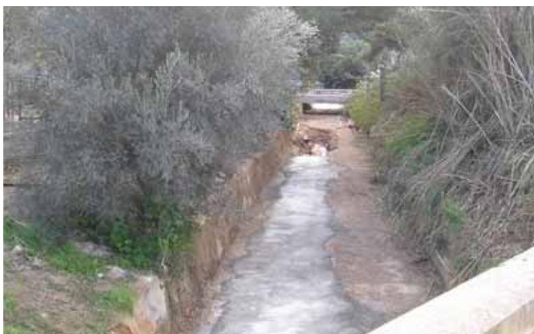
**FIGURA 6.** Restitución a su estado inicial de la superficie afectada por la zanja en un torrente.
