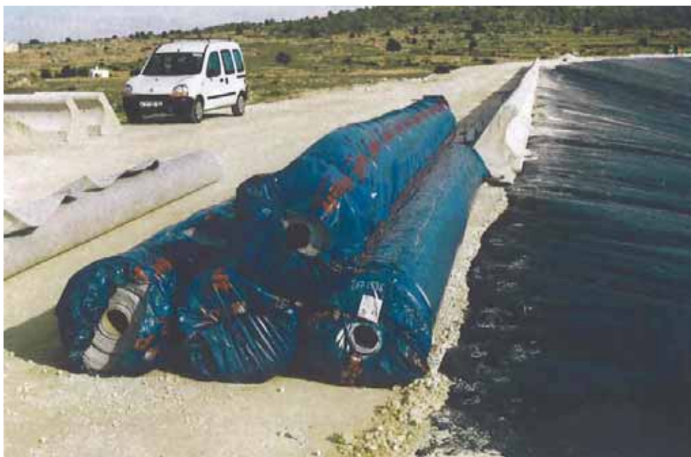
FIGURA 1. Rollos de geotextil recepcionado en el embalse de El Toscar.
