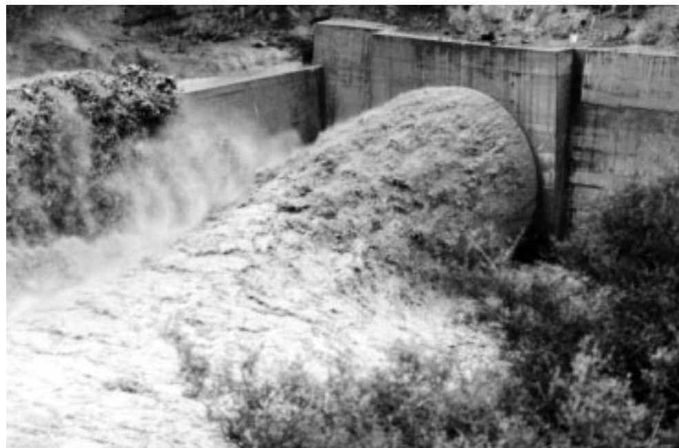
FIGURA 7. Salida del túnel de desvío derecho de la Presa de Beni Haroun durante una crecida.
