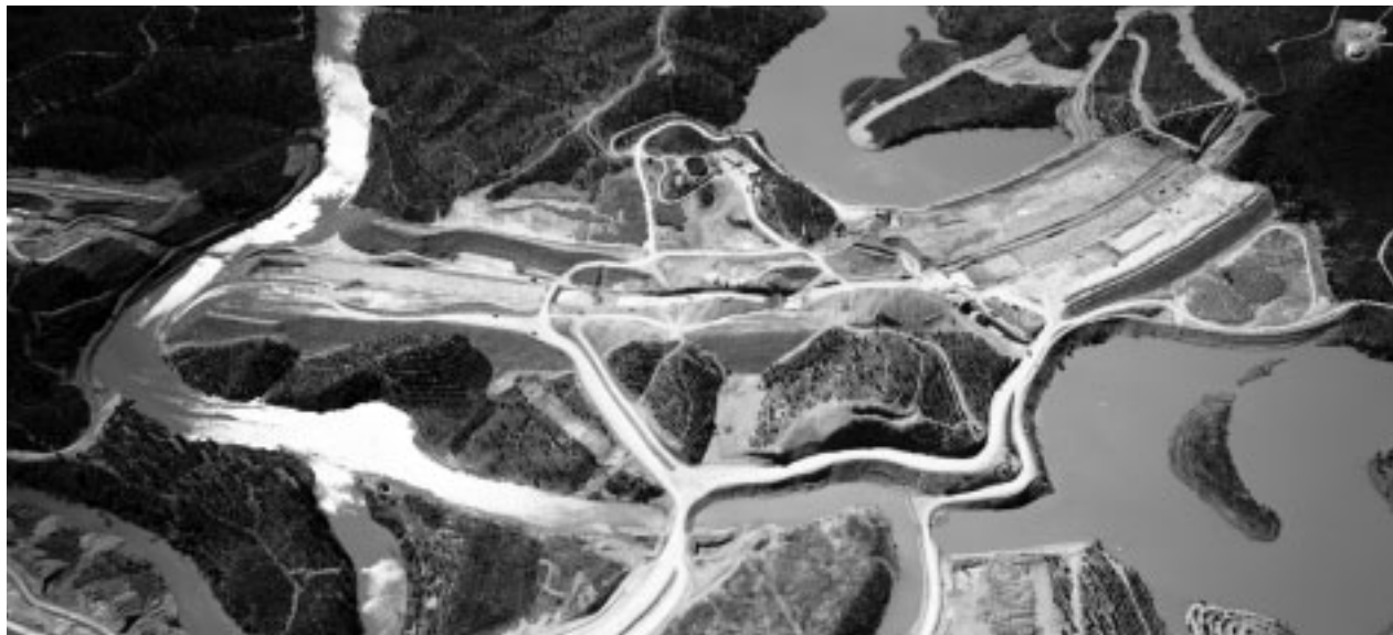
FIGURA 1. Primera Etapa del desvío provisional en la Presa de Andévalo, a través del valle del Cobica. Vista Aérea.
