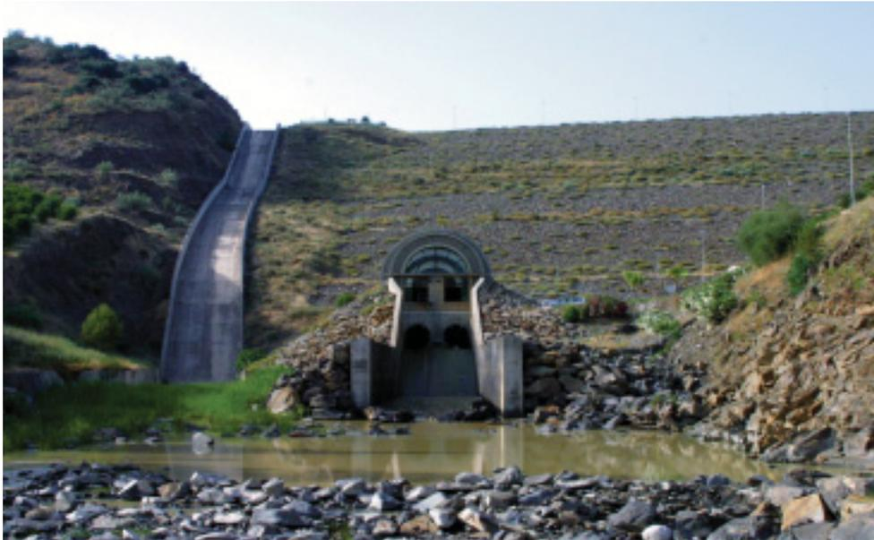
**FIGURA 6.** Presa de la Viñuela. Vista desde el pie de aguas abajo. Se aprecia el aliviadero de superficie sobre la ladera derecha y la cámara de válvulas n°2 del desagüe de fondo.
