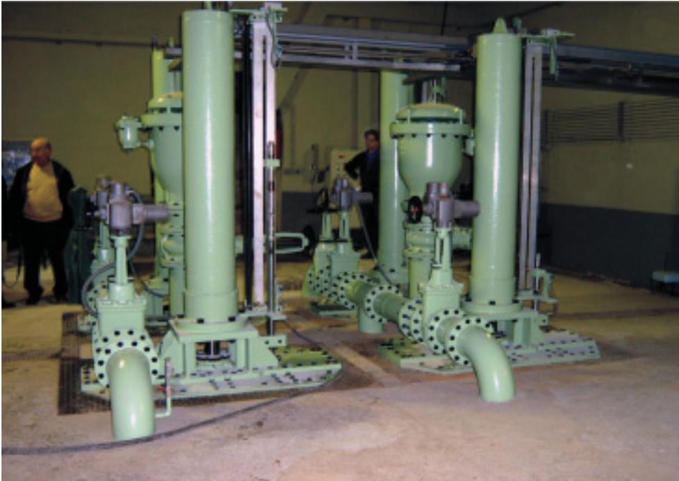
**FIGURA 3.** Cámara de válvulas nº1. Vista desde aguas abajo de los conductos del by-pass y de los testigos de elevación de las dos compuertas Bureau de cada conducto del desagüe de fondo, además de sendas ventosas situadas entre las compuertas Bureau de cada desagüe.
