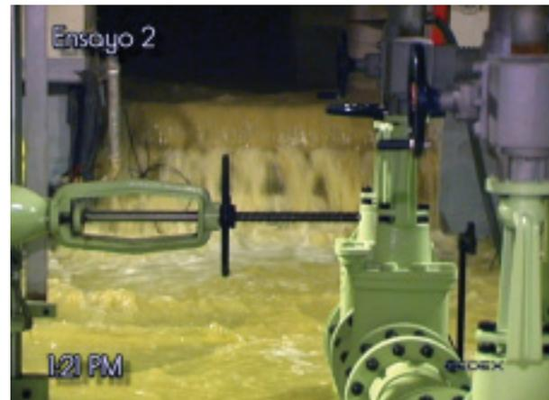
**FIGURA 16.** Imagen obtenida con la cámara de video externa, muestra el estado de la cámara de válvulas nº1 instantes después del vaciado del agua del conducto de aducción de aire, que se evacua por la torre de tomas y por el túnel que discurre sobre los conductos del desagüe de fondo.
