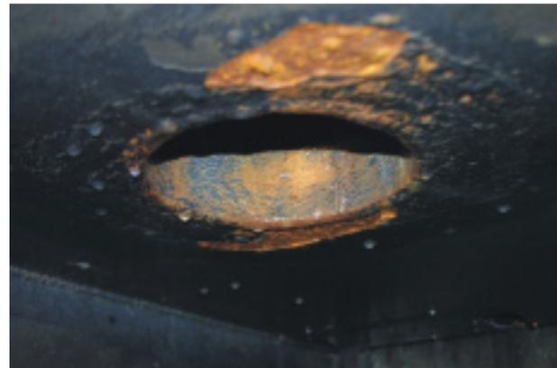
**FIGURA 4.** Tablero de la segunda compuerta Bureau del desagüe izquierdo. Imagen tomada desde aguas abajo desde el tramo de carrete rectangular. Se aprecia en la parte superior el orificio de salida del by-pass. Adjunto se presenta el detalle del orificio de salida del conducto del by-pass de  $\Phi 200$  mm.
