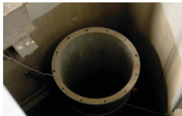
**FIGURA 5.** Vista del tubo de aducción de aire del desagüe de fondo izquierdo  $\Phi 600$  mm dentro de la torre de tomas.
