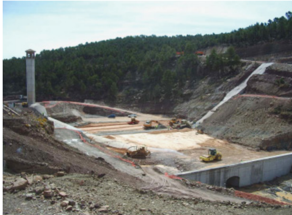
FIGURA 1. Vista de las labores constructivas desde aguas abajo de la presa.
