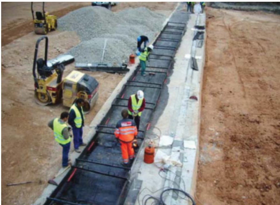
FIGURA 3. Ejecución de la primera tongada del núcleo asfáltico.
