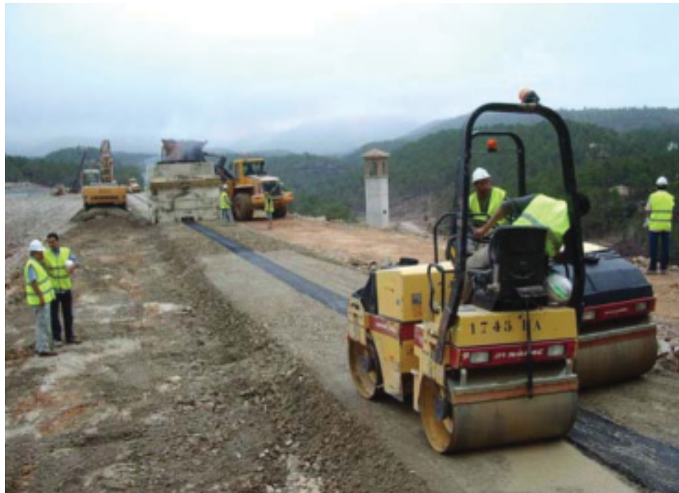
FIGURA 4. Colocación de la última tongada del núcleo asfáltico.
