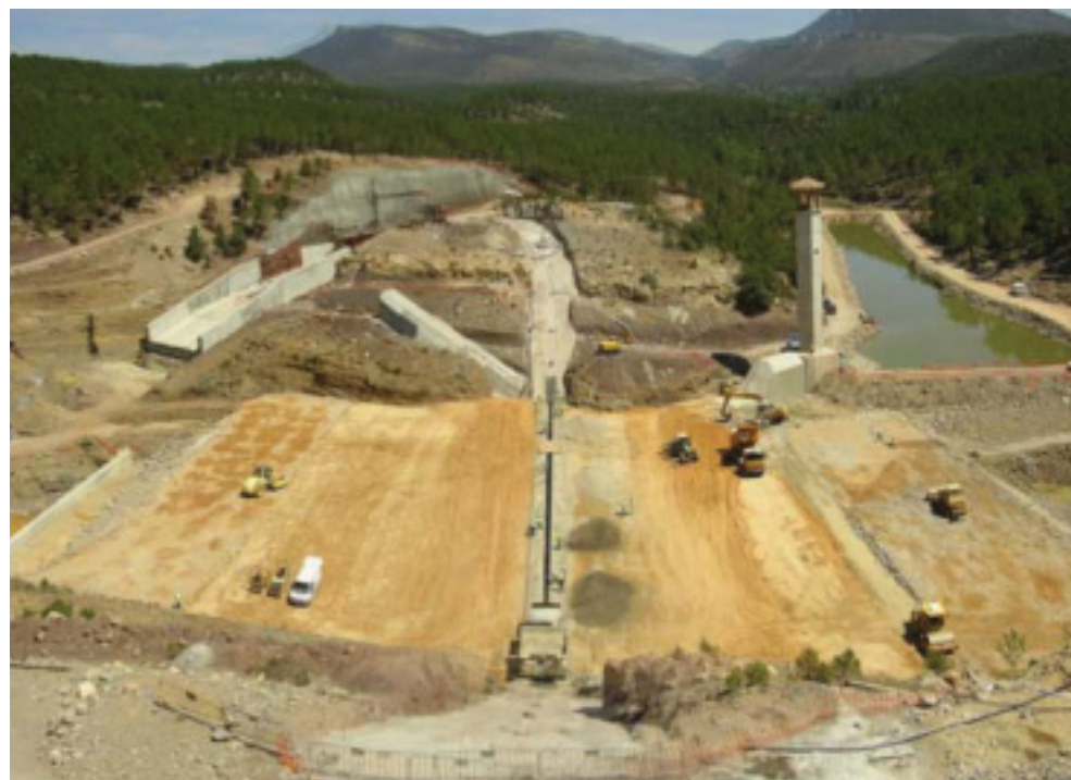
FIGURA 2. Vista de las obras desde el estribo izquierdo.
