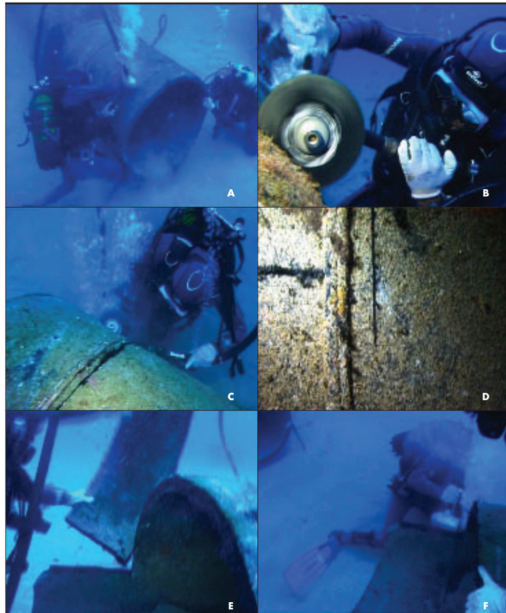
FIGURA 5. Diversos momentos en el corte de la tubería
