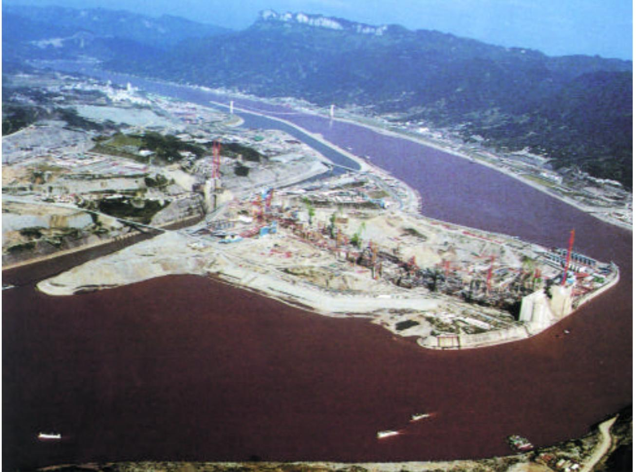
Foto 3: Vista de la presa en construcción desde aguas arriba. Por la derecha fluye el Yangtze en la segunda fase de su desvío; se construye en el recinto ce de ataguías de 72 metros de altura, la central izquierda de pie de presa y la zona de aliviaderos; a la izquierda se construyen las estructuras de navegación. Cuerpo de presa en construcción (septiembre 2000)
