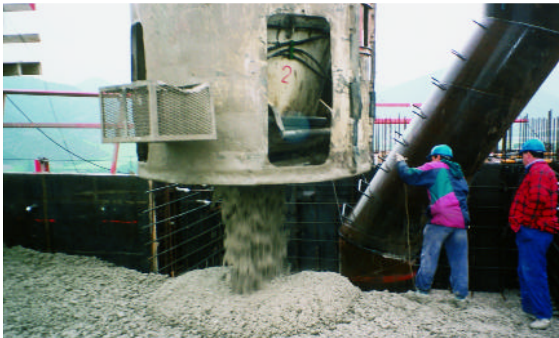
Figura 16. Puesta en obra del hormigón.
