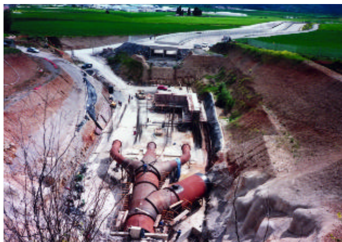
Figura 10. Toma del canal de Navarra. Caseta de
