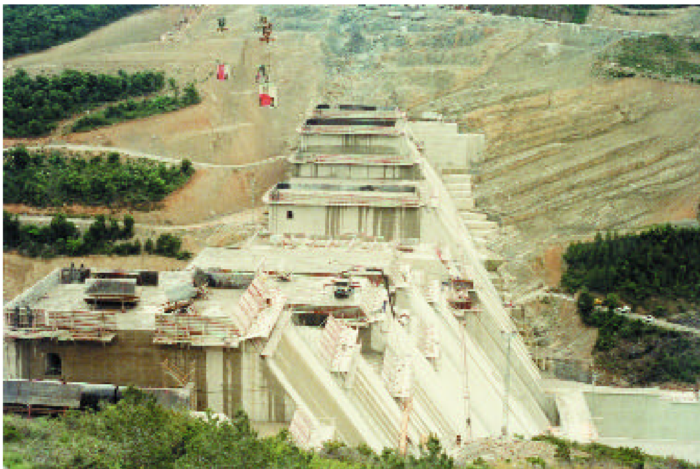
Figura 15. Transporte de hormigón con los blondines.
