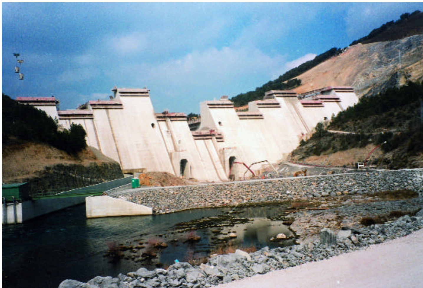
Figura 12. Contraatagüa y canal del desvío.
