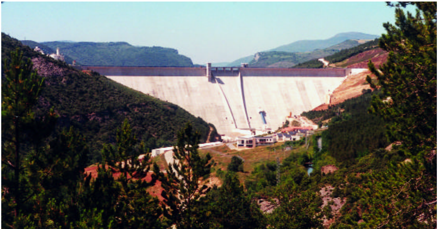
Figura 1. Presa de Itoiz. Vista desde aguas abajo.
