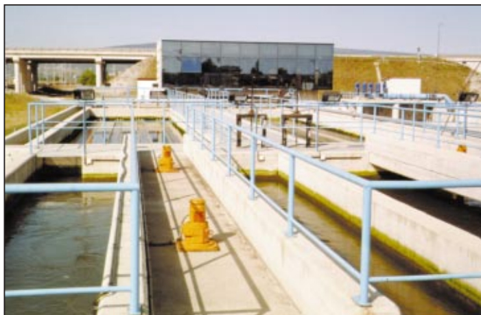
Planta de tratamiento terciario para riego agrícola en Vitoria.
