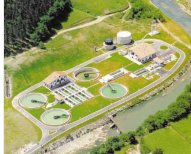
Depuradora de Azpeitia-Azkoitia.
