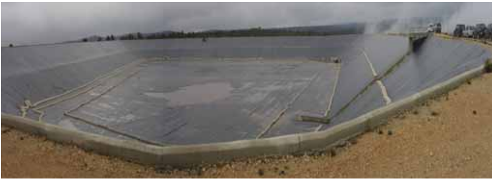
FIGURA 3. Balsa de Calderones (Valencia) impermeabilizada con PEAD.
