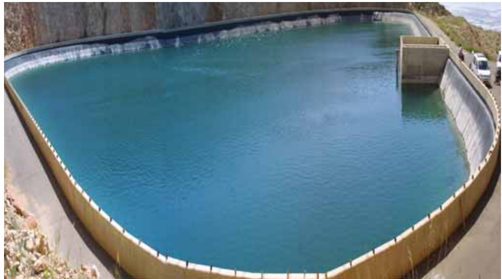
FIGURA 4. Balsa del Cerrillo del Libro (Almería) impermeabilizada con PEMBD.
