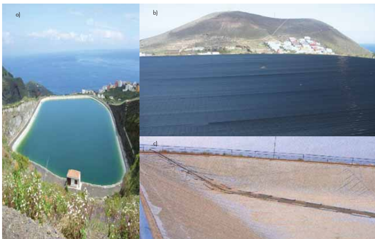
FIGURA 2. a) Balsa de Bediesta (Isla de La Palma) impermeabilizada con una geomembrana de PVC-P. b) Balsa cubierta de Ravelo (Tenerife) con pantalla impermeable de EPDM. c) Balsa de cubierta flotante de Agudulce (Almería) con barrera geosintética polimérica de CSM.
