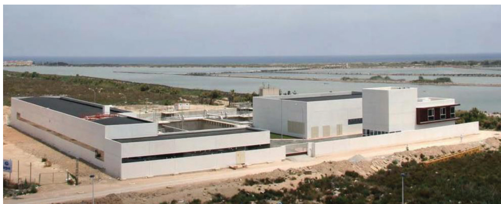
FIGURA 11. Vista general de la EDAR de San Pedro del Pinatar, Murcia.
