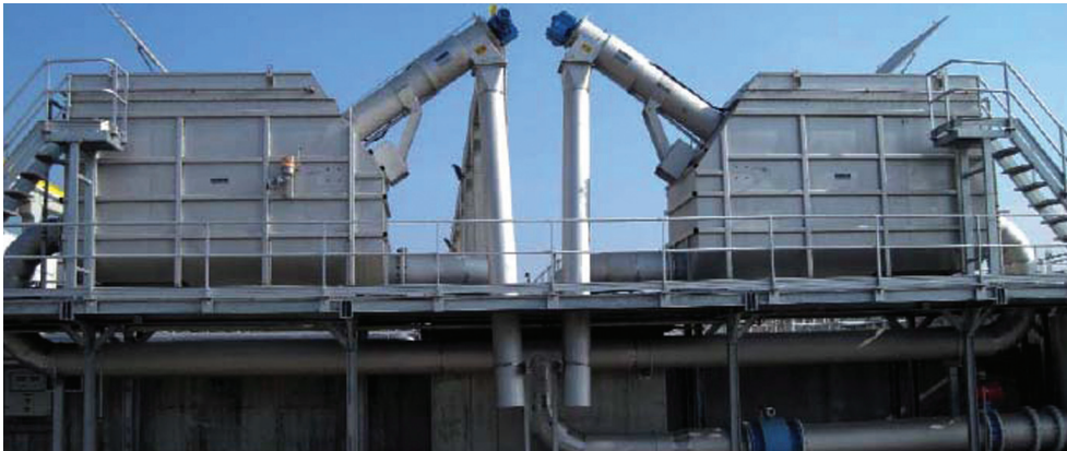
FIGURA 7. Tamices rotativos de malla de 2 mm en EDAR de Sabadell-Riu Sec, Cataluña.
