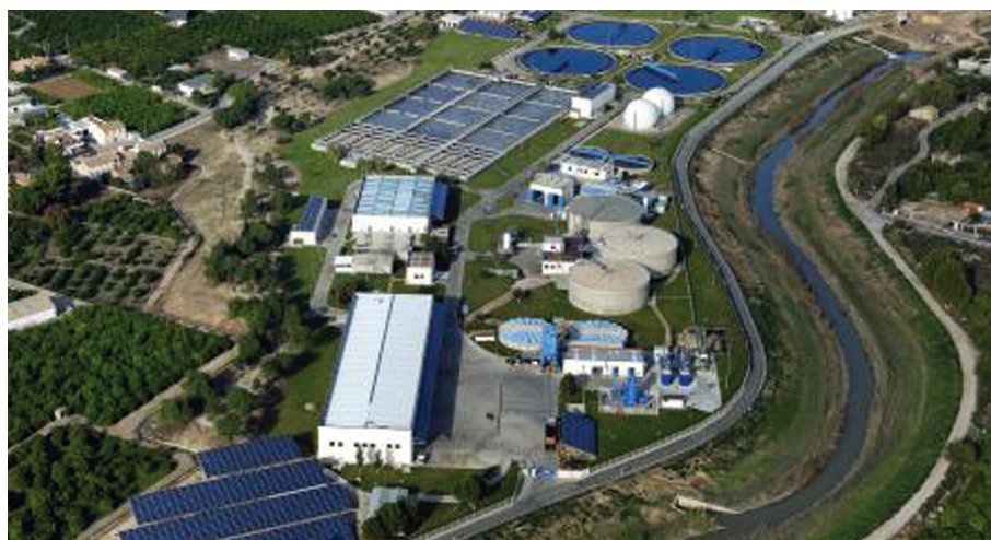
FIGURA 37. Paneles fotovoltaicos EDAR Murcia Este.
