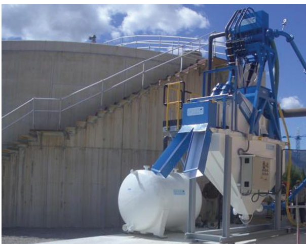
FIGURA 32. Limpieza en continuo del digester anaerobio de EDAR Alcantarilla mediante el ciclonado del fango digerido.
