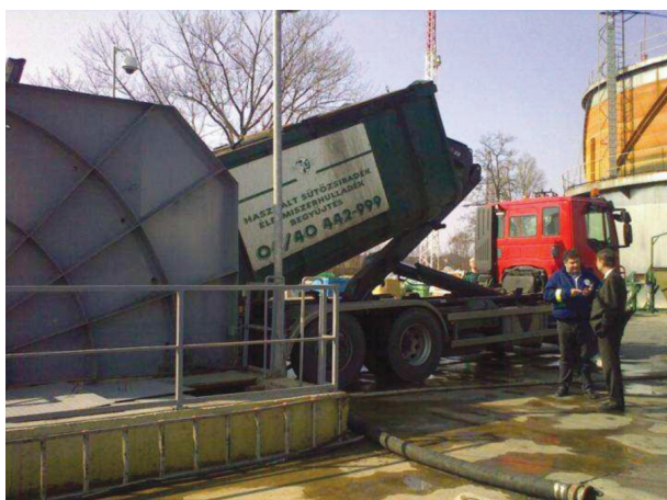
FIGURA 2. Recepción de producto sólido a tolva de recepción (Sistema ECRUSOR, Veolia).
