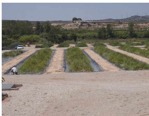
FIGURA 10. EDAR de Fabara (Zaragoza). Fuente: ETS Ing. Agrónomos. UPM.
