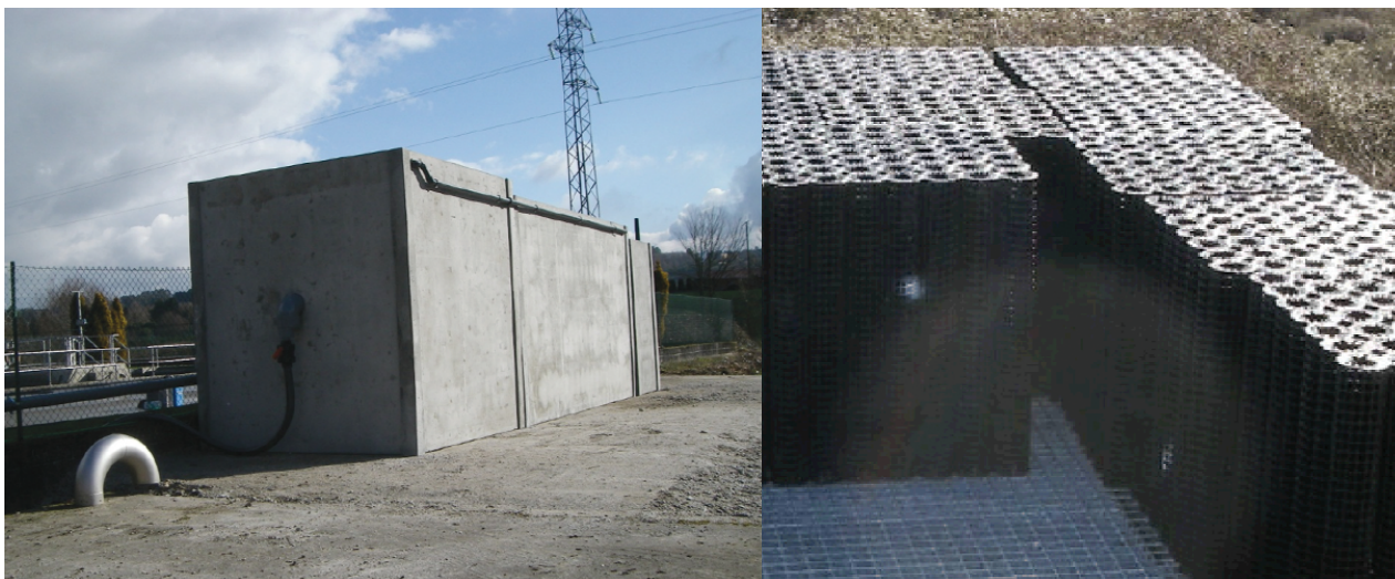
FIGURA 16. Reactor SAF y relleno estructurado (Bionet) (EDAR de Quenllo).
