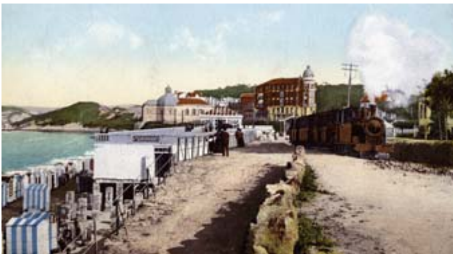
FIGURA 9. Construcción del paseo marítimo del Sardinero (postal de la época).
