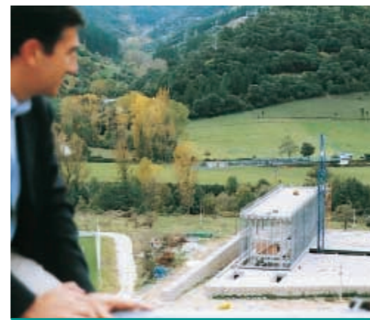
▲ Lista de las obras, junto al arquitecto autor del Proyecto. Foto: Eduardo C. de Bello
