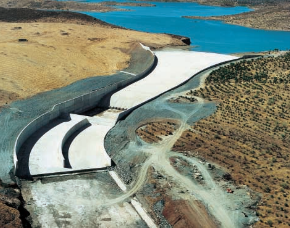
■ Nuevo aliviadero. Rehabilitación de la presa de Los Molinos. Confederación Hidrográfica del Guadiana.
