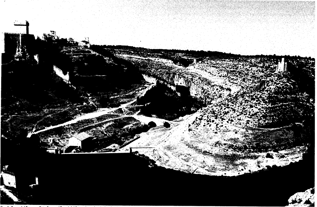
Fig. 5. Toma del Trasvase Tajo-Segura (Canal del Picazo) en el embalse de Alarcón.
