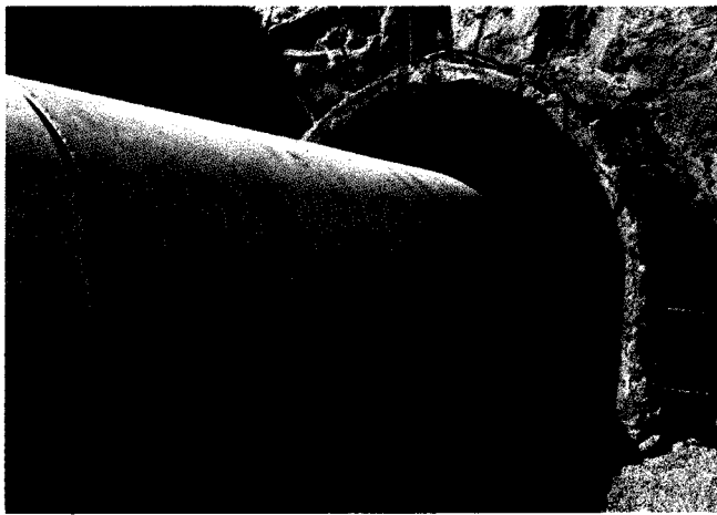
Fig. 2. Túnel del Coll de Balaguer.
