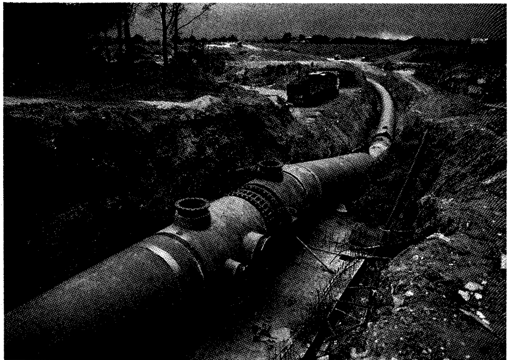
Fig. 6. Vista general de las obras de instalación de tuberías.
