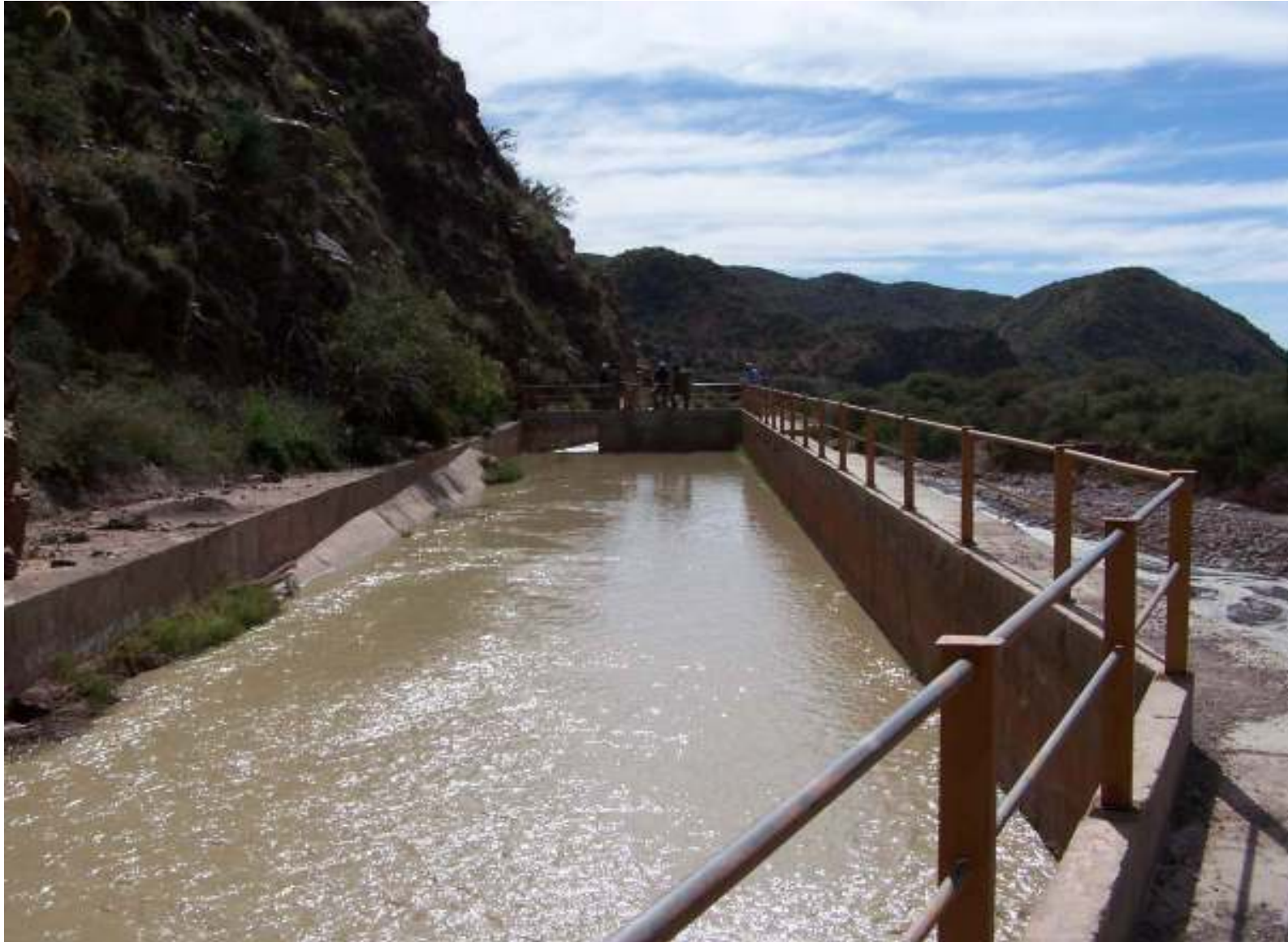
Azud de derivación y toma-parrilla CHAÑARMUYO, sección hidráulica del decantador y vano de salida a canal (ítem 124)
