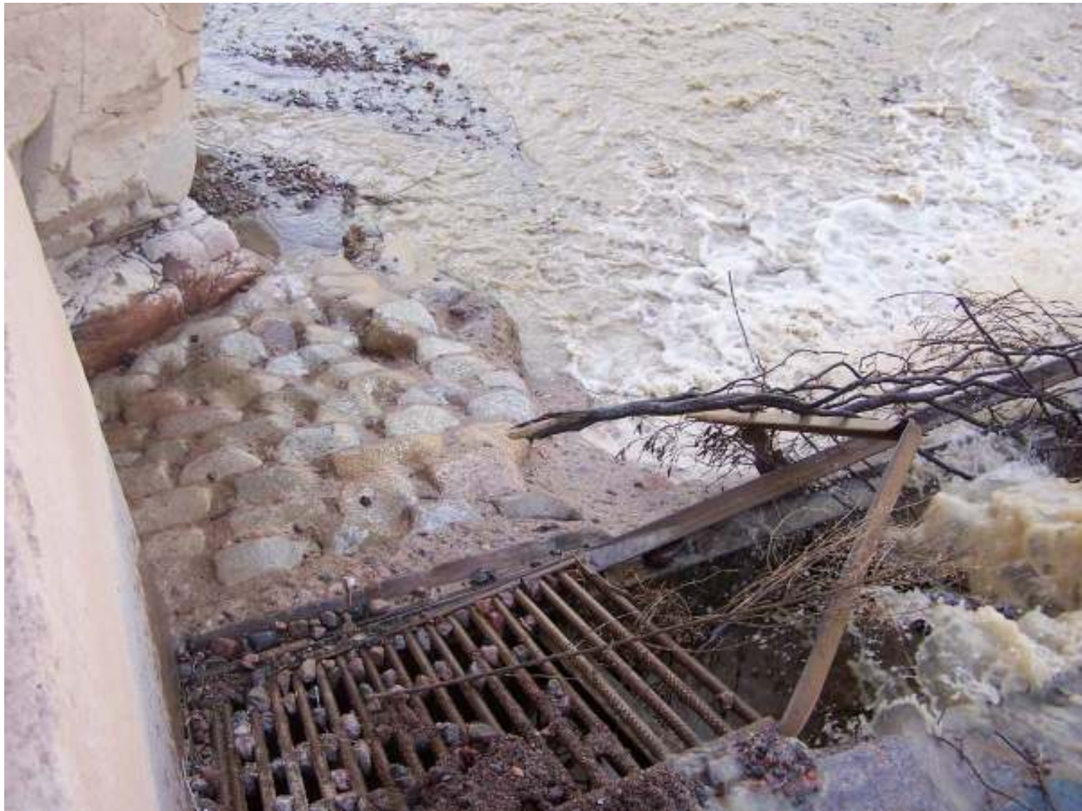
Azud de derivación y toma-parrilla CHAÑARMUYO, reja de protección del vano de toma (ítem 120)
