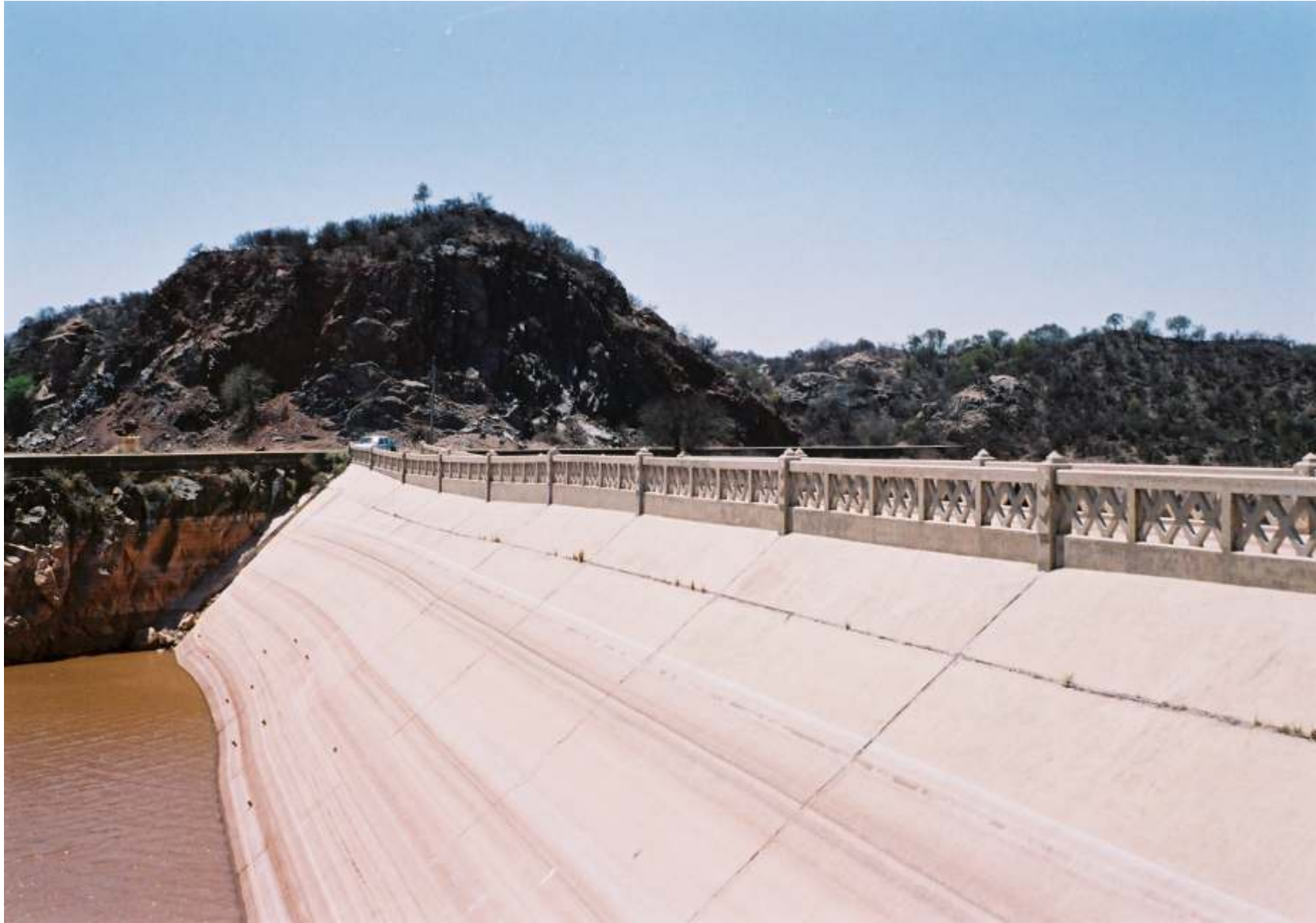
Presas de embalse ANZULÓN, deformación de la pantalla por asentamiento de la escollera (ítem 108)
