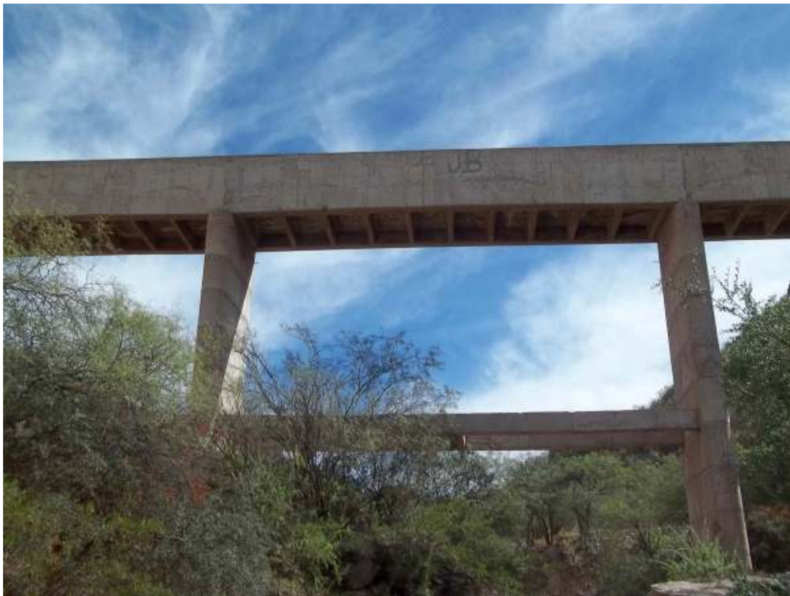
Canal de alimentación a embalse CHAÑARMUYO, tramo de puente-canal (ítem 127)
