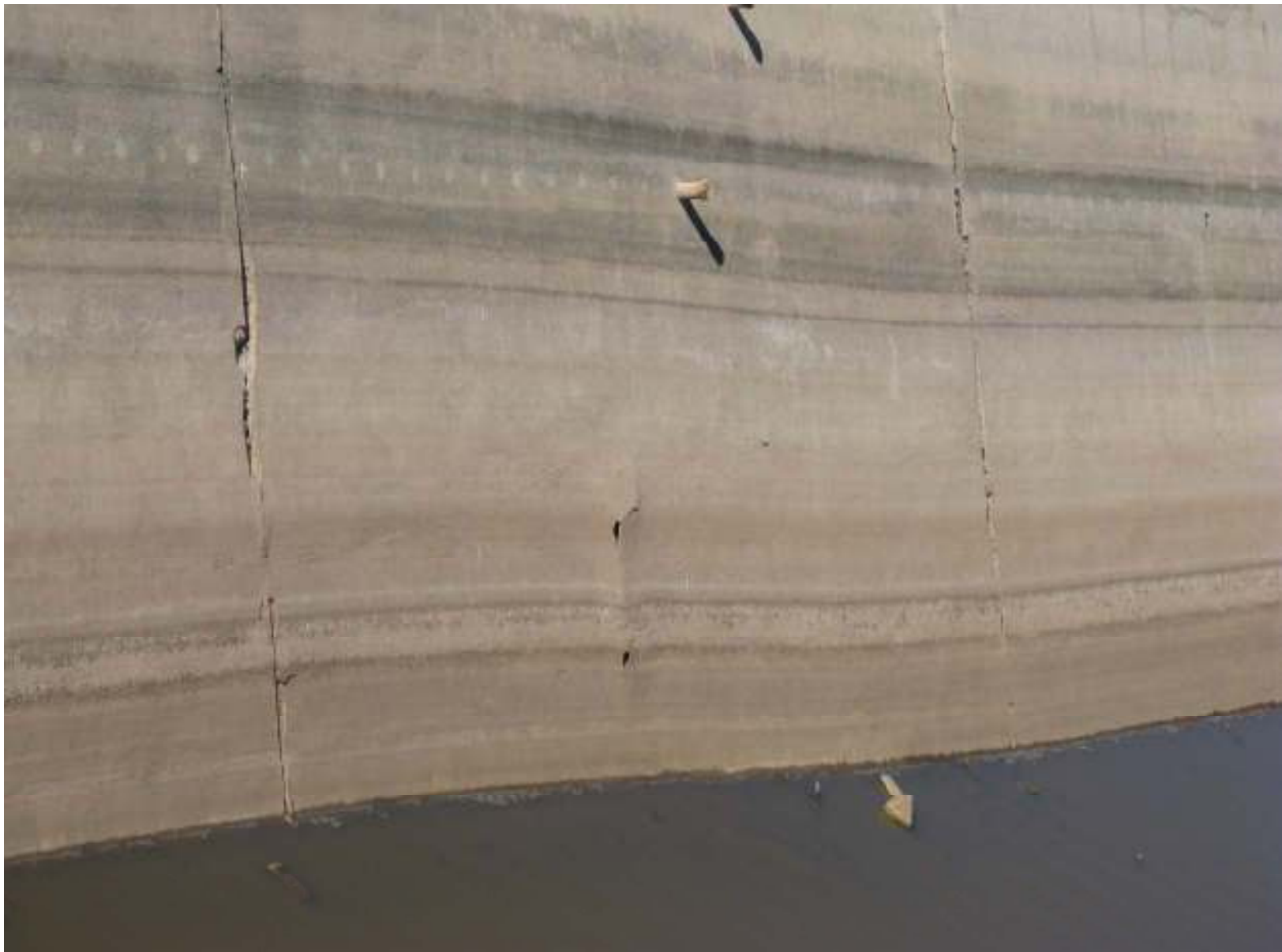
Presas de embalse ANZULÓN, detalle de las juntas y superficie de las losas de la pantalla (ítem 109 y 110)
