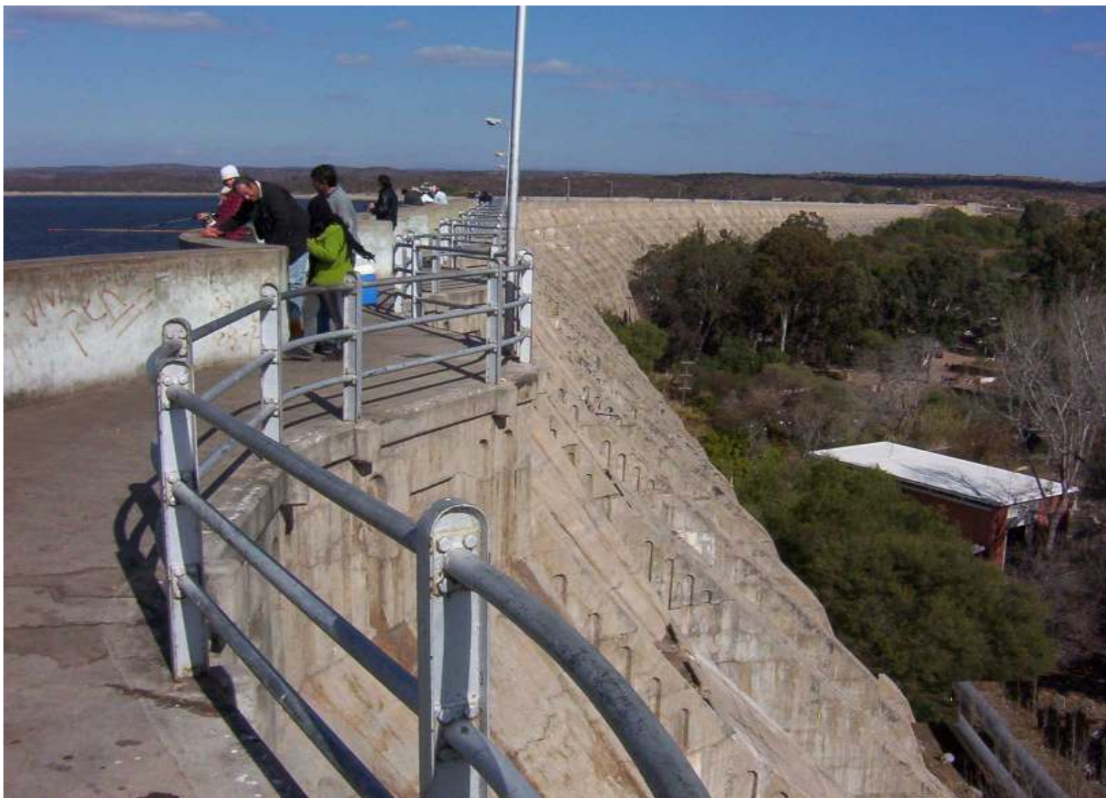
Presas de embalse CRUZ DEL EJE, pie de presa con intrusión vegetal y ocupación edilicia (ítem 99)
