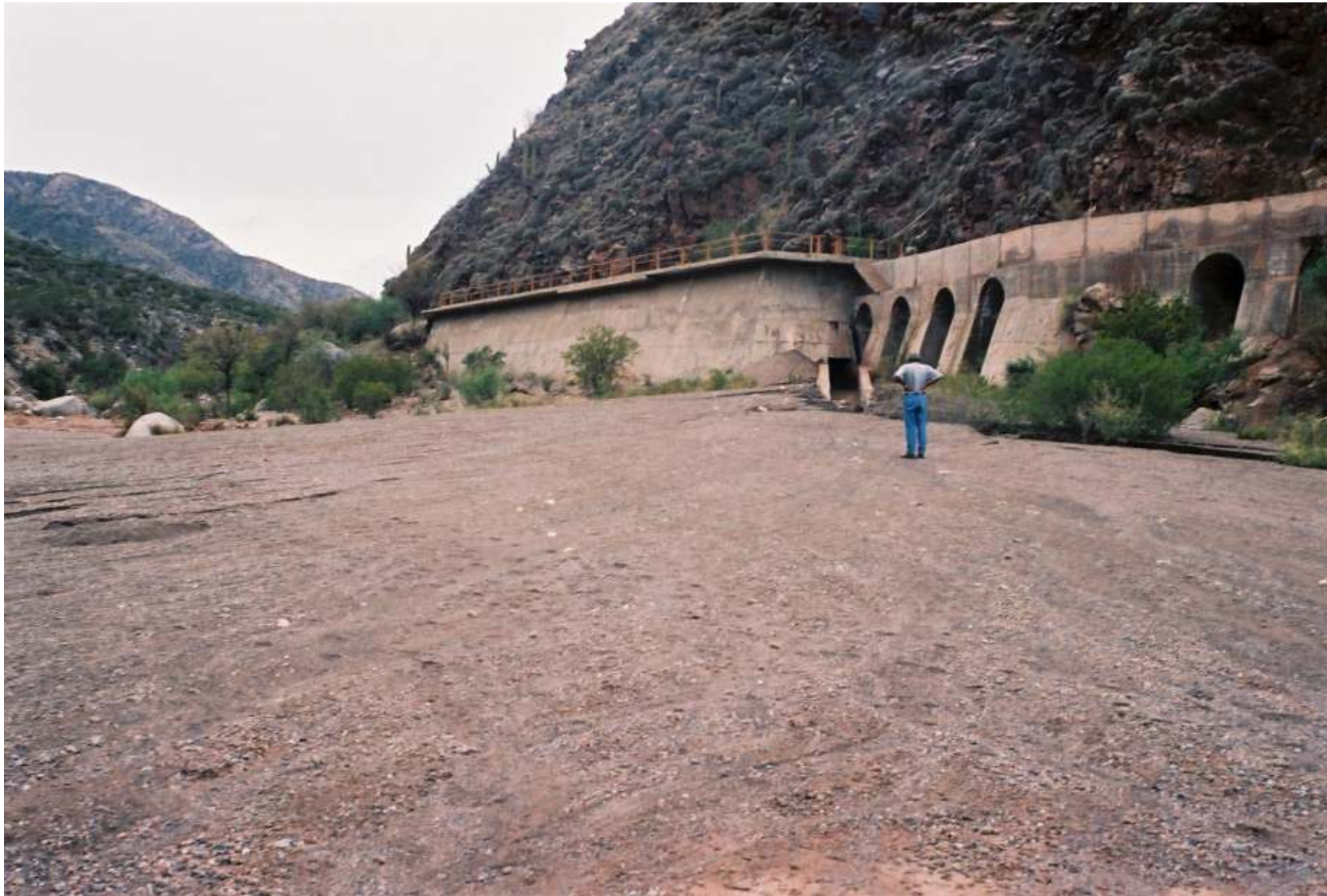
Azud de derivación y toma-parrilla CHAÑARMUYO, vista general del decantador y depósito de material residual (ítem 123)
