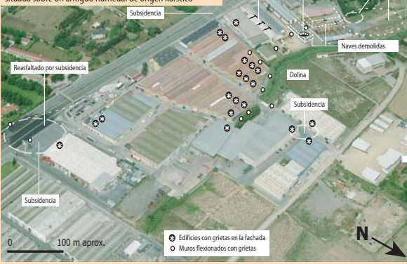
Cuadro 2. Daños actuales observados en una zona industrial situada sobre un antiguo humedal de origen kárstico
