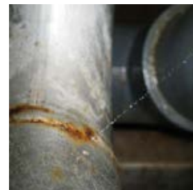
Fig. 3 – Ejemplo de tubería de acero con corrosión interior y tubería de acero inoxidable con una fuga.
