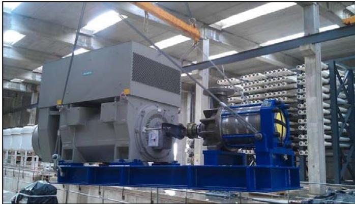
*Figura 3. Instalación de uno de bombeos de alta presión*
