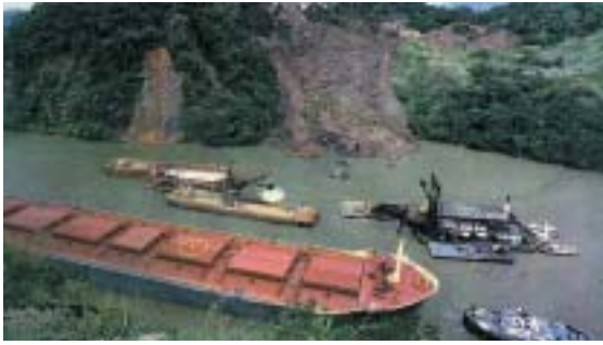
Tareas de dragado en el Canal de Panamá luego de que una serie de deslizamientos transversales alteraran la navegación, en 1986. http://pubs.usgs.gov/of/2001/ofr-01-0276/images.html
