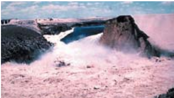
Ultima fase del colapso de la presa Teton, en junio de 1976. Murieron 11 personas y los costos económicos fueron de 11 millones de dólares. http://www.pn.usbr.gov/dams/Teton.shtml
