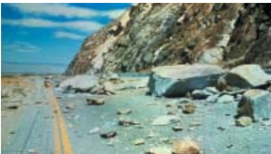
Los desprendimientos activados por movimientos sísmicos fueron un problema para las vías de comunicación en California, en 1986. http://bearcat.ublyk12.mi.us/earthpics.html
