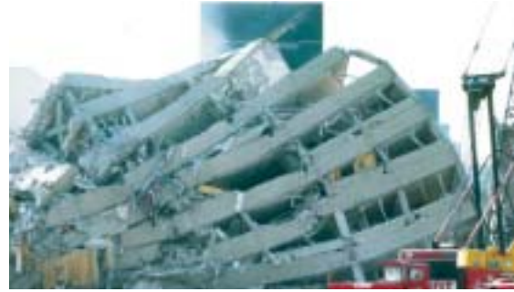
Colapso de importantes edificios en México luego del terremoto del año 1985. http://newweb.www.paho.org/spanish/ped/Mexico.html
