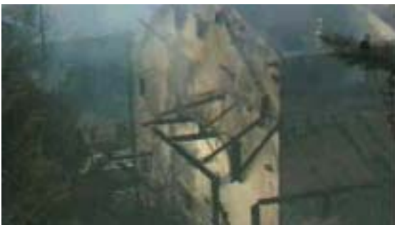
Cuando los incendios se producen en los campos, la infraestructura agropecuaria puede resultar seriamente afectada.
