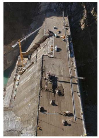
de 1.220 mm de ancho y 35 m de longitud. Posteriormente, entre el buzón regulador y el sitio más alto de la presa ubicado en la ribera derecha, se utilizaba una cinta de 760 mm de ancho y 100 m de largo. Las condiciones del terreno hicieron necesario la construcción de un túnel para la disposición de esta cinta transportadora.
