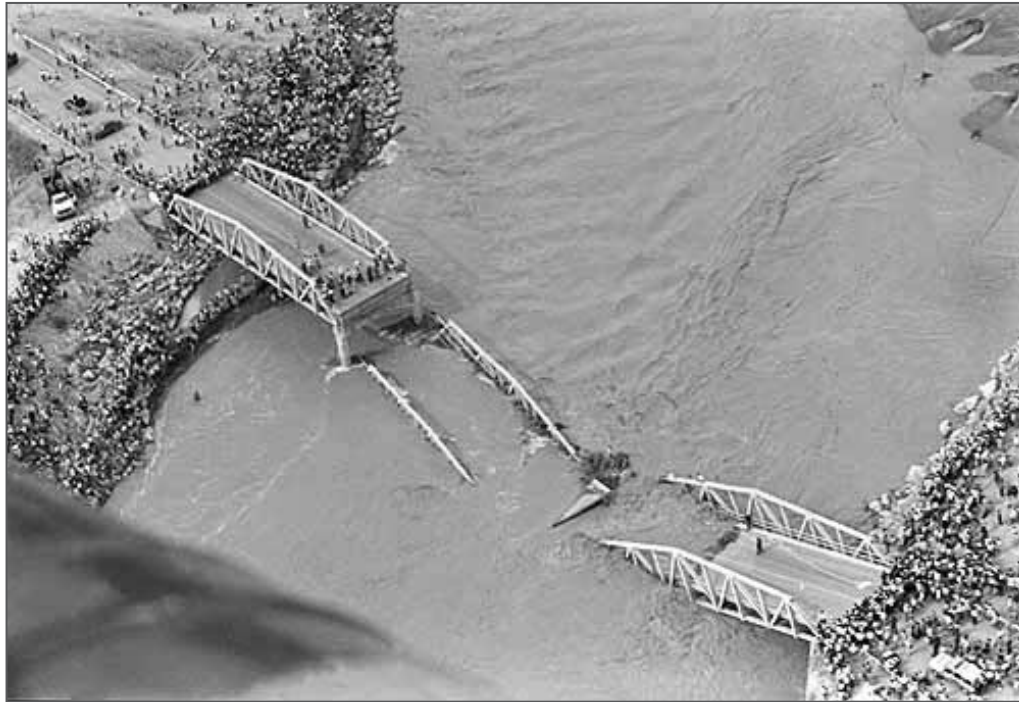
GRÁFICO 9: SITUACIÓN DE PUENTE LUEGO DE CRECIDA Y DESBORDE DEL RÍO REQUE (LAMBAYEQUE, PERÚ 1998)
