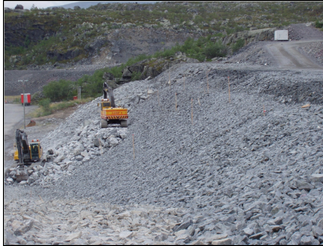
Foto 1. Construcción de la protección tipo repi  de la presa de Suorva (Fuente: Nilsson 2004)
