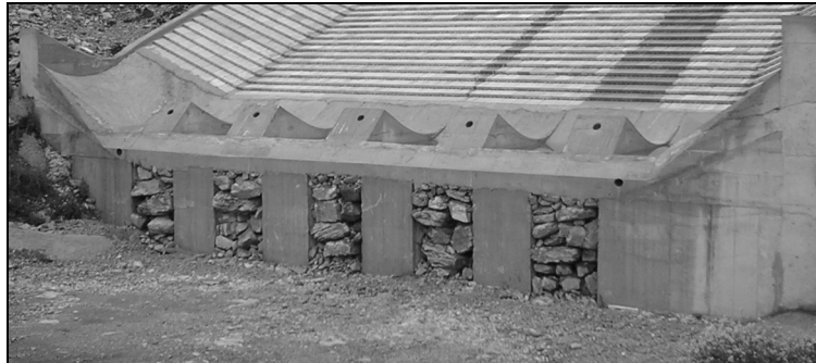
Foto 3. Imagen del trampolín de restitución con los orificios de drenaje de escollera y los de aireación en los dientes de reparto
