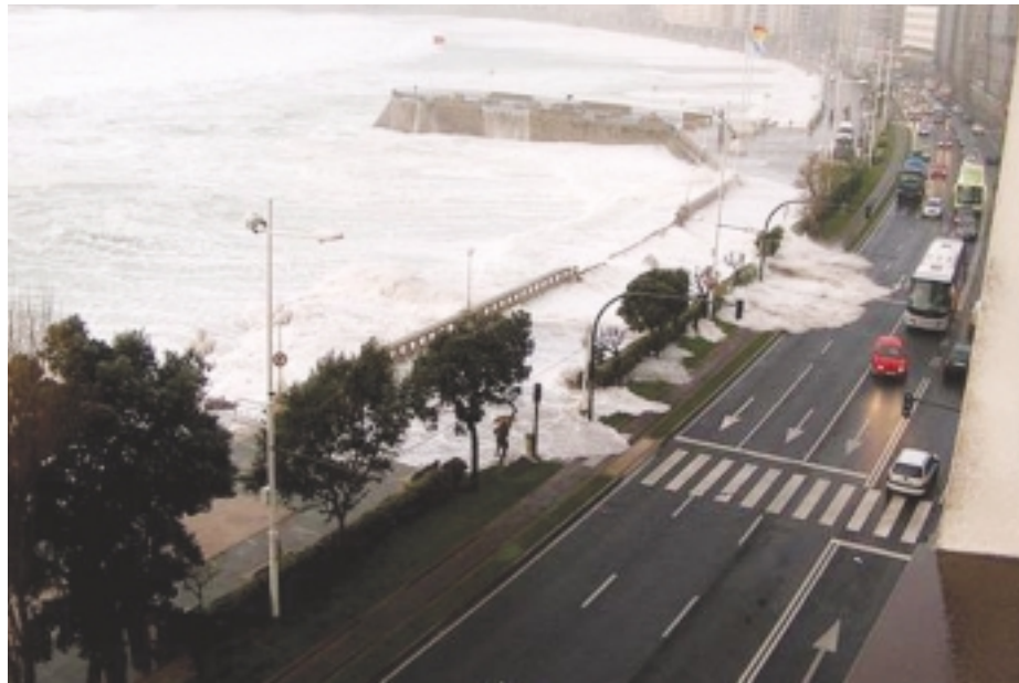
FIGURA 4. La Coruña las olas rebasan la balaustrada (B.Iglesias-internet).
