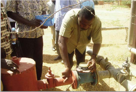
Forage artésien, Banizoumbou, Niger
