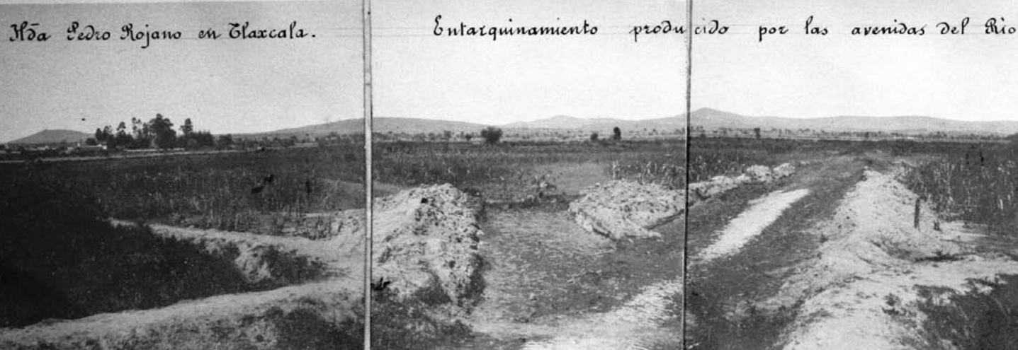
Obras hidráulicas para entarquinar terrenos de la hacienda San Pedro Rojano, propiedad de Francisco Sola, con aguas del arroyo Xolotlaco, 1910, Lardizábal, Tlaxcala. AHA, Aprovechamientos Superficiales, caja 1073, expediente 15073.v
