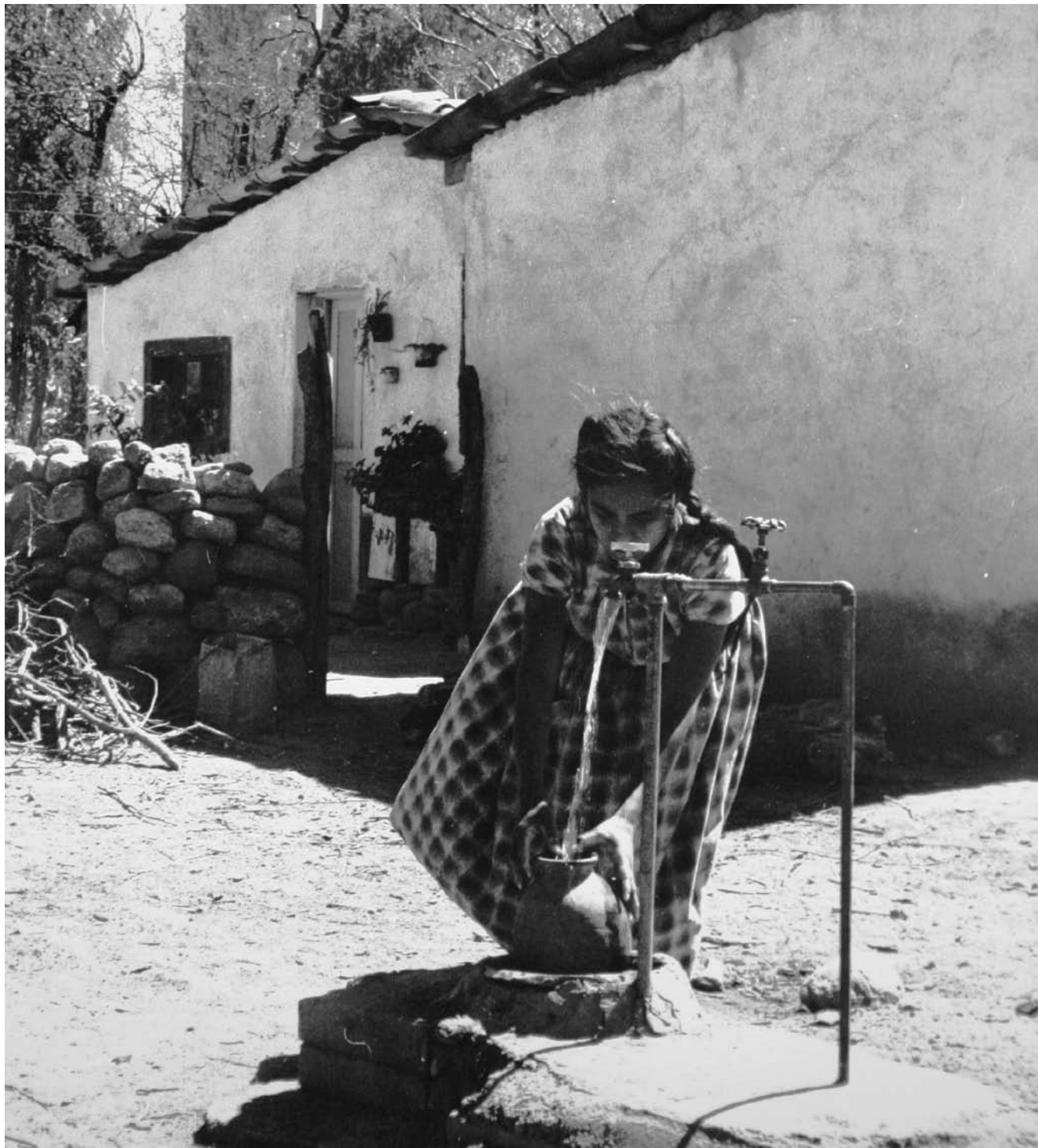
Toma domiciliaria en la población de Corralejo, construida por la SRH, 1961, Pénjamo, Guanajuato. AHA, Colección Fotográfica, caja 595, expediente 16671.
