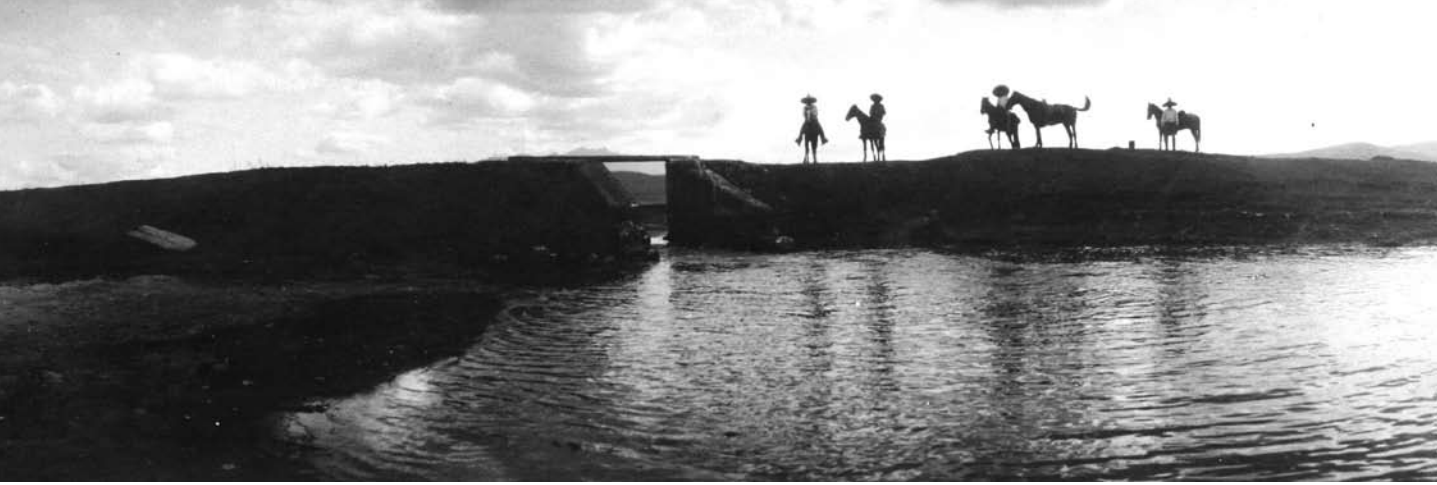
Bordo de la caja de agua de la hacienda San Isidro, ubicado sobre el río La Patera, 1907, Coeneo-Huaniqueo, Michoacán. AHA, Aprovechamientos Superficiales, caja 262, expediente 6314.
