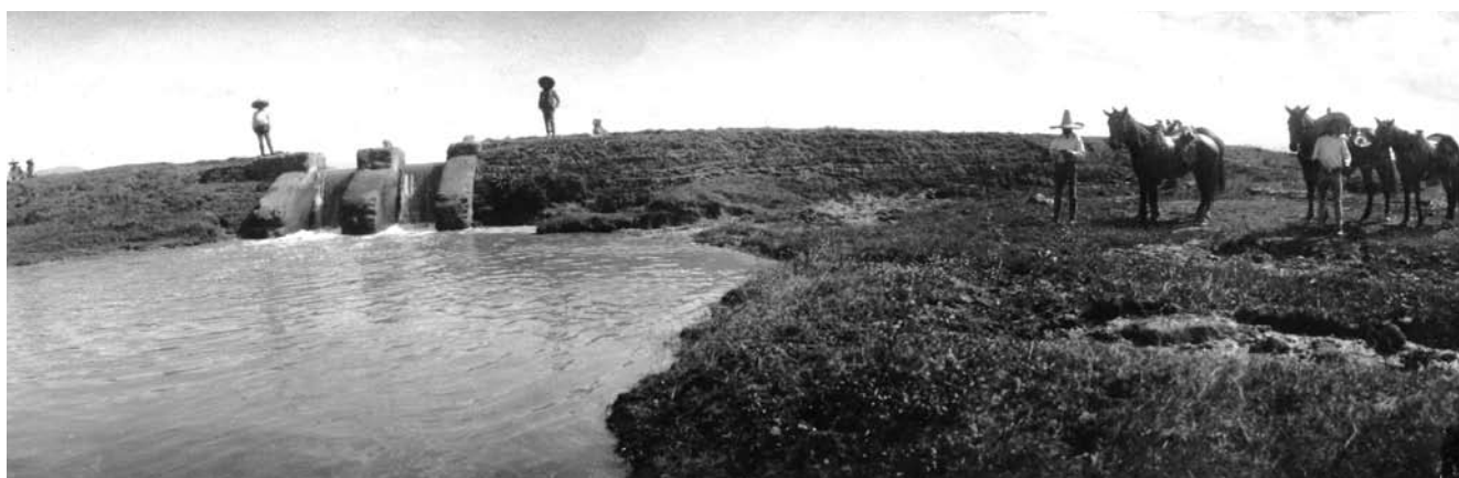
Compuertas del bordo de la caja de agua del rancho El Durazno, desfogando agua al río La Patera, 1907, Coeneo-Huaniqueo, Michoacán. AHA, Aprovechamientos Superficiales, caja 262, expediente 6314.
