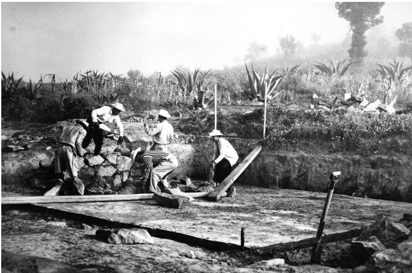
Desplantando el muro para el tanque de almacenamiento de agua potable en San Pedro Elacotepec, 1963, Xalostoc, Tlaxcala. AHA, Colección Fotográfica, caja 243, expediente 6821.
