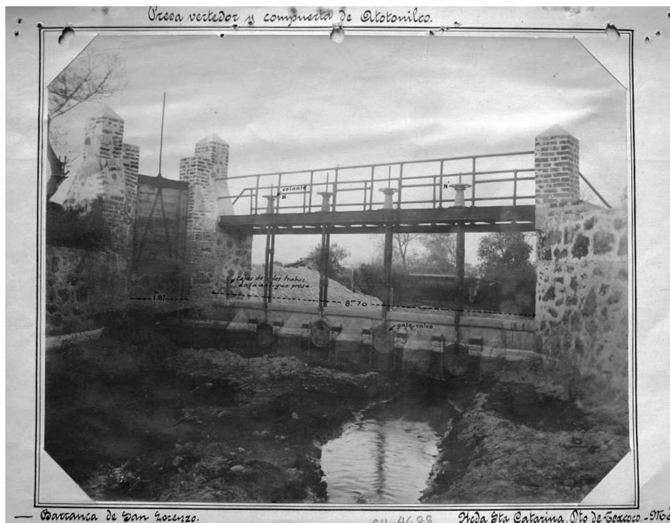
Presa y compuerta de Atotonilco para derivar agua de la barranca de San Lorenzo Hostotipac u Ometepep, para regar y enlamar terrenos de la hacienda Santa Catarina Ajapuzco, 1914, San Juan Teotihuacán, Edo. de México. AHA, Aprovechamientos Superficiales, caja 1180, expediente 16481.
