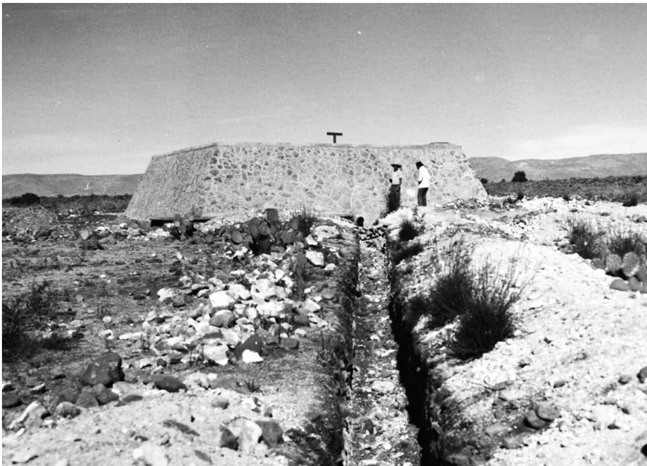
Tanque de almacenamiento de agua potable y cepa para la instalación del hidrante público, 1976, San Diego de la Unión, Guanajuato. AHA, Colección Fotográfica, caja 1297, expediente 39333.
