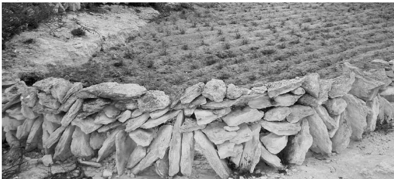
Fotografía 3. Vista de una jolla localizada en la parte alta (inicio) de un arroyo seco
