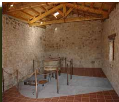
◀ Figura 3. Rehabilitación de molino.
