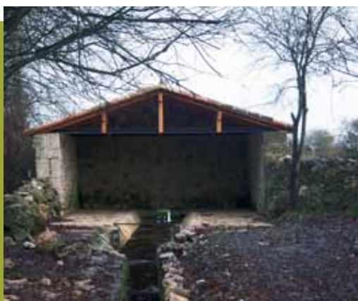
Figura 3. ► Rehabilitación de lavadero.
