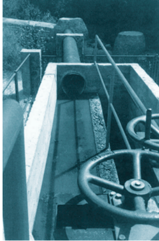
FOTOGRAFÍA 1. Colector y aliviadero en la obra de llegada a la EDAR.
