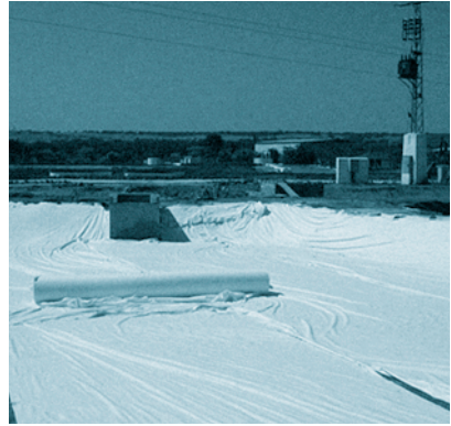
FOTOGRAFÍA 5. Colocación de la lámina de geotextil.
