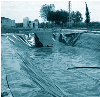
FOTOGRAFÍA 6. Humedal tras finalizar la etapa de impermeabilización.
