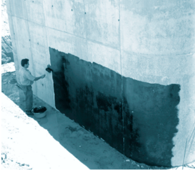
FOTOGRAFÍA 29. Impermeabilización de las paredes.
