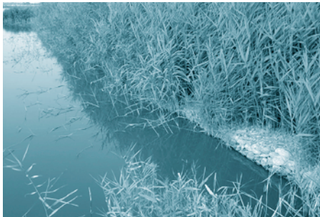
FOTOGRAFÍA 45. Filtro de piedra a la salida de un lagunaje. En este caso el filtro se ha plantado con carrizo.
