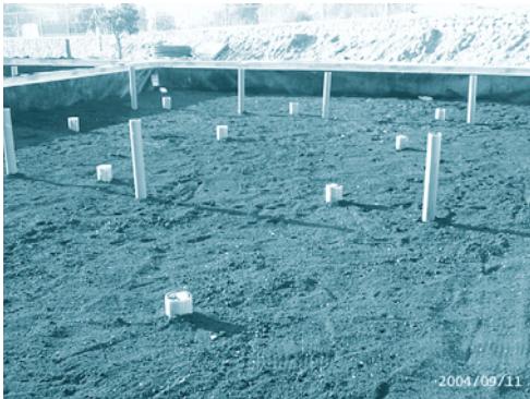
FOTOGRAFÍA 9. Turba ya colocada, se aprecian las chimeneas de alimentación y los soportes (tubos cortos) para las tuberías de reparto.
