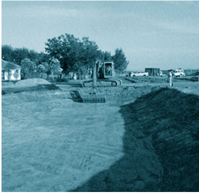
FOTOGRAFÍA 4. Excavación del vaso de los humedales.
