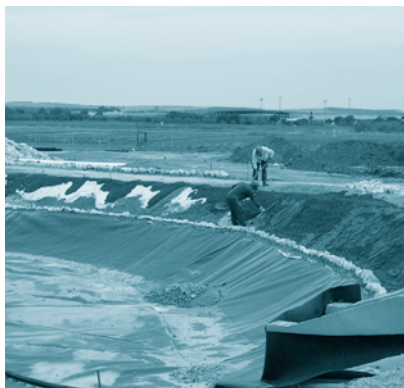
FOTOGRAFÍA 35. Preparación de los taludes para su encachado.
