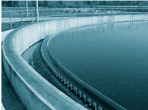
FOTOGRAFÍA 16. Decantador secundario.
