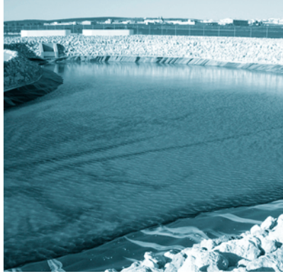
FOTOGRAFIA 37. Llenado de una laguna facultativa.
