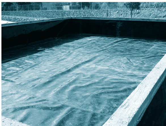
FOTOGRAFÍA 5. Filtro de turba con la solera impermeabilizada con lámina plástica de PEAD.
