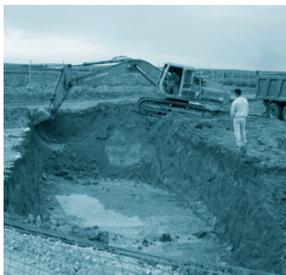
FOTOGRAFÍA 27. Excavación del vaso de lagunas anaerobias.
