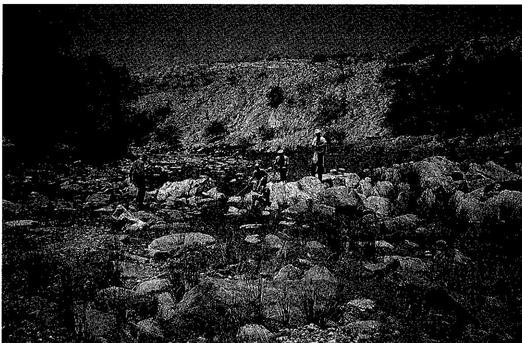
Fotografía 2.2. Zona de filtraciones del embalse de Oanob, Namibia. El agua procede de los niveles más superiores del embalse.
