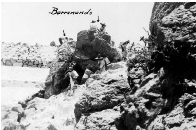
Trabajos de barrenado en las obras de la Presa de Mexquitic, 1925, San Luis Potosí. AHA, Aprovechamientos Superficiales, caja 1608, expediente 22990.
