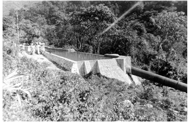
Vista de conjunto de obras. Final del canal, tanque desarenador con su vertedor y arranque de la tubería de presión, 1941, Ciudad Valles, San Luis Potosí. AHA, Aprovechamientos Superficiales, caja 1179, expediente 16466.
