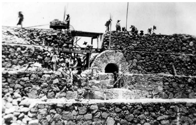
Trabajos de enrocamiento en la Presa Mexquitic, 1925, Mexquitic, San Luis Potosí. AHA, Aprovechamientos Superficiales, caja 1608, expediente 22990.
