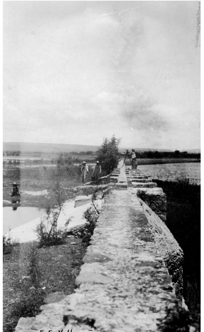
Cortina de la Presa de San Francisco, 1928, Villa de Reyes, San Luis Potosí. AHA, Aprovechamientos Superficiales, caja 1296, expediente 17711.
