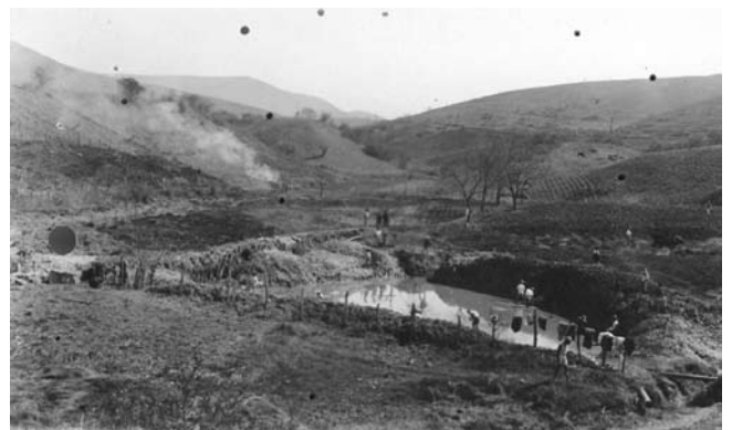
Presa de tierra donde nacen los manantiales, dando principio a los trabajos de limpieza y desazolve, 1930, Cárdenas, San Luis Potosí. AHA, Aprovechamientos Superficiales, caja 278, expediente 6701.
