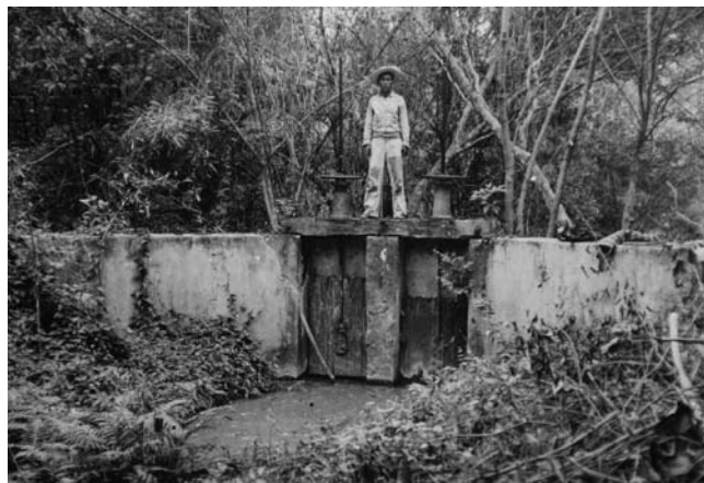
Obra de toma sobre el río Choy, utilizada por los vecinos del lugar para riego de terrenos, 1944, Hacienda El Limón, Tamuín, San Luis Potosí. Colección de Estudios y Proyectos de la Biblioteca Central de la CONAGUA, Anaquel 47, Entrepañó A, Número 5.
