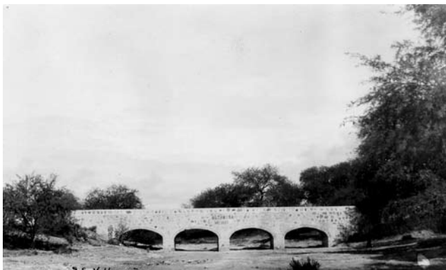
Puente-canal Moctezuma sobre el río de Altamira, 1928, Villa de Reyes, San Luis Potosí. AHA, Aprovechamientos Superficiales, caja 1296, expediente 17711.
