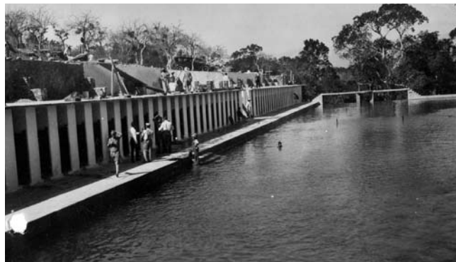
Partidor de agua al que le llaman presa, construido de mampostería de piedra, que también es utilizada por los lugareños para actividades agrícolas y recreativas, 1932, Río Verde, San Luis Potosí. AHA, Aprovechamientos Superficiales, caja 1.307, expediente 17835.
