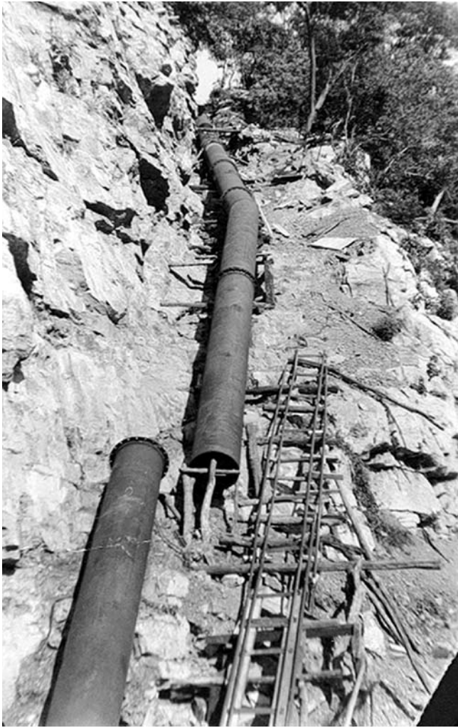
Tuberías de la Compañía Hidroeléctrica del Río Micos, 1941, Ciudad Valles, San Luis Potosí. AHA, Aprovechamientos Superficiales, caja 1179, expediente 16466
