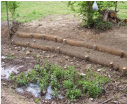
Biorrollos en la margen derecha del cauce.
