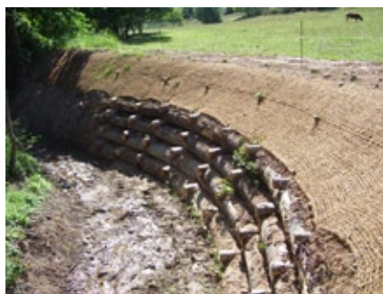
Muro Krainer con vegetación incipiente sobre la malla orgánica.
