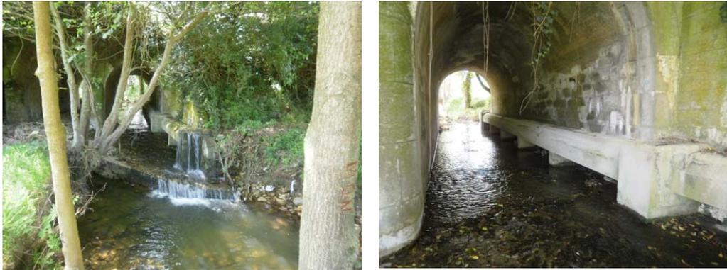
Colector de margen del arroyo de A Barranca bajo el puente del FFCC, en cuyo pozo aguas abajo se produce un rebose continuo de sus aguas fecales.
