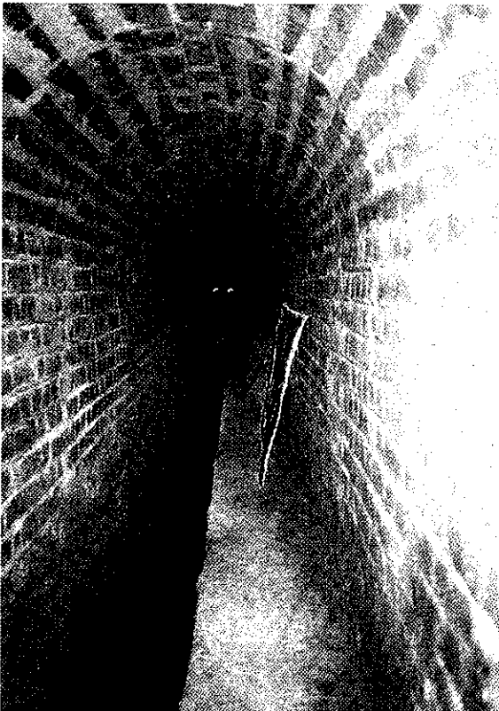
Galería del Bajo Abroñigal: antigua captación de aguas para abastecimiento de Madrid.
