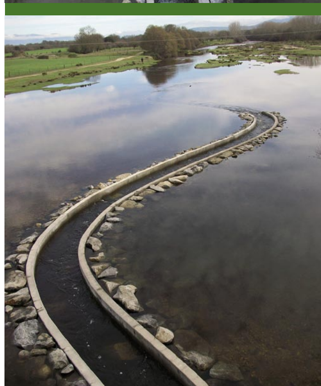
▲ Distintas imágenes sobre la evolución de las obras en el azud
